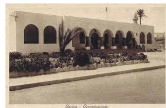
صورة (3) لمبنى المتصرفية
